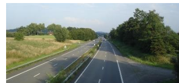
Vue sur l'autoroute depuis le pont de Salles-Mongiscard, à l'extrémité nord du site Natura 2000
